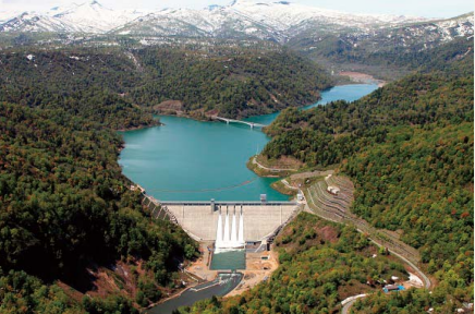
土木 樺戸(二期)農業水利事業 徳富ダム [北海道]
