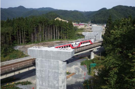
土木 国道45号 小本道路工事 [岩手県]
